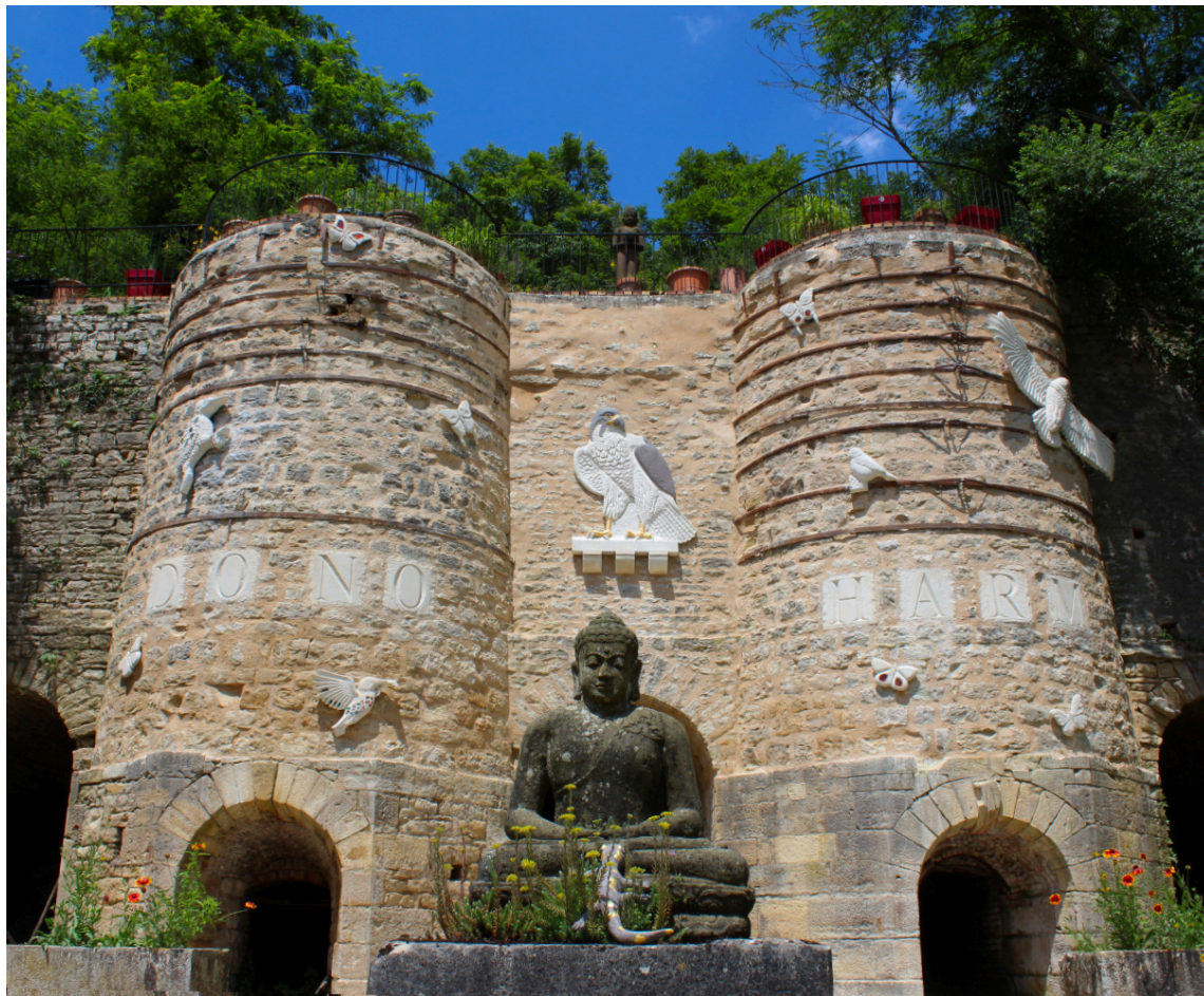
Anciens fours à chaux de Nanteuil-en-Vallée.
