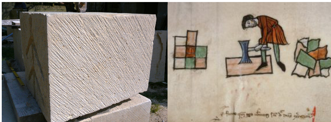
A gauche le parement d'une pierre layée, à droite une enluminure représentant un tailleur de pierre au XIIIe siècle, Amiens.
